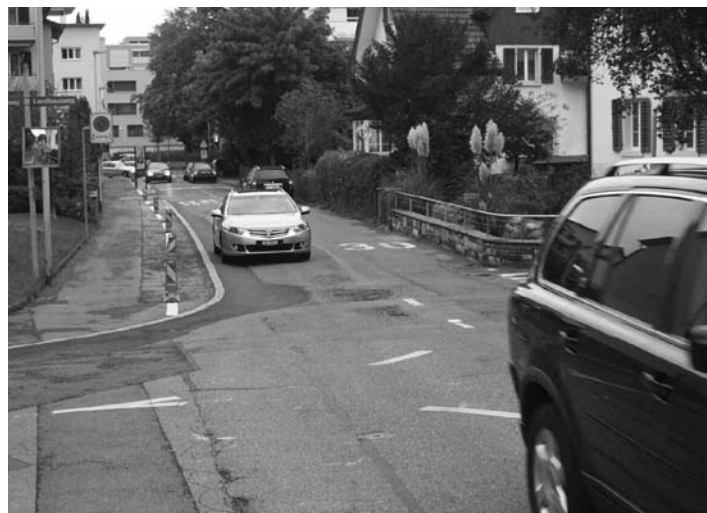
Einer der Knackpunkte: der Lüssiweg. Auf Kosten der Fussgänger soll die Strasse breiter werden, wogegen sich der Quartierverein wehrt.
