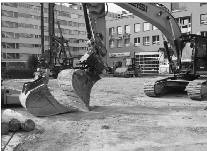
Baarerstrasse/Garage Huber AG: Aushub und Fundamentierung zurzeit.
