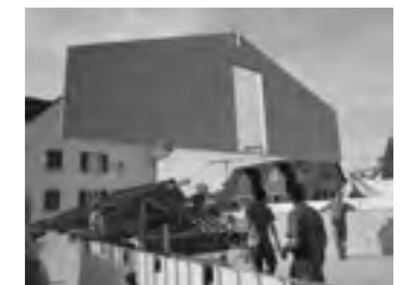
Trockenbauteile werden gesetzt...
