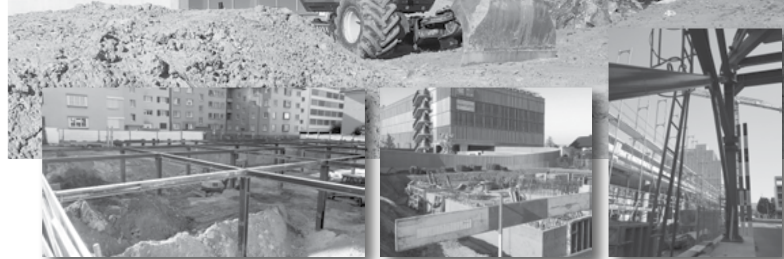
Wohn- und Geschäftshaus am Tirolerweg.
